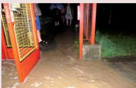
Zaplavené koupaliště - hlavní vstup
