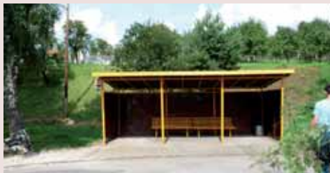
Rekonstrukce zastávky a úprava okolí
