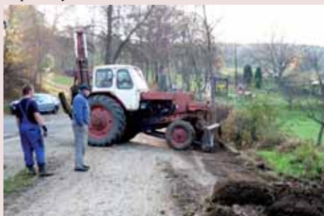
Práce na protizáplavových opatřeních
