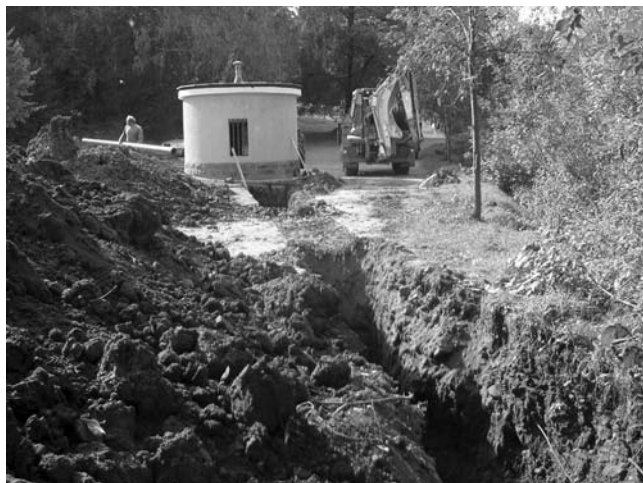
Oprava kanalizace kyselky
