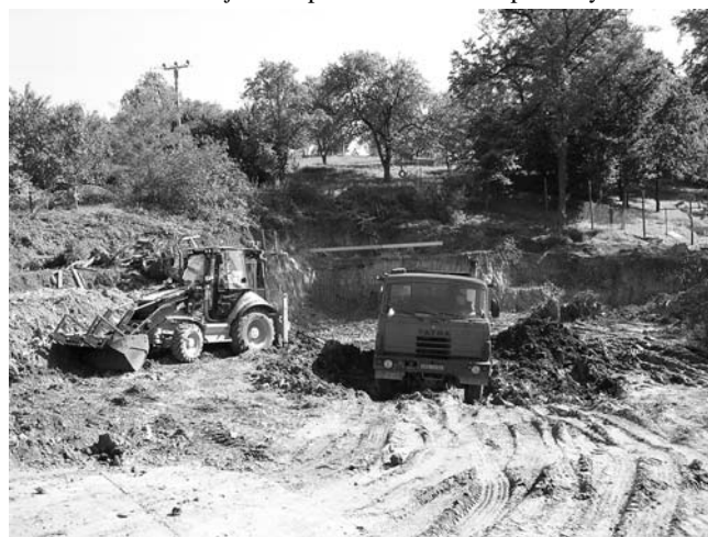
Zahájení výkopových prací na tělocvičně
