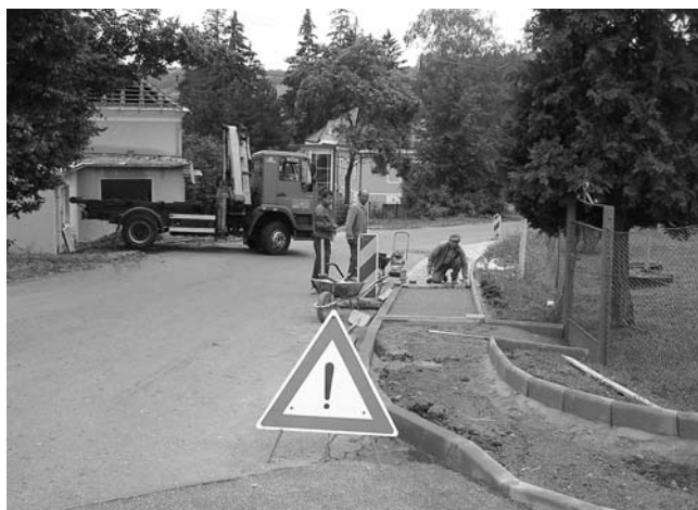
Oprava chodníku u pošty
