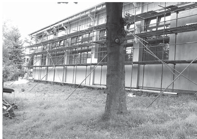
Dokončovací práce na fasádě
