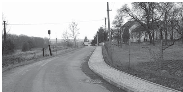
Oprava chodníku k nádraží
