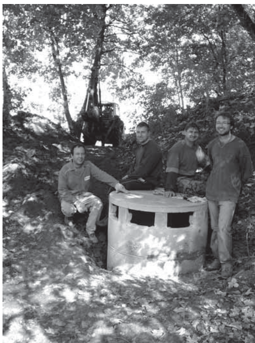
Kanalizace na sjezdovce
